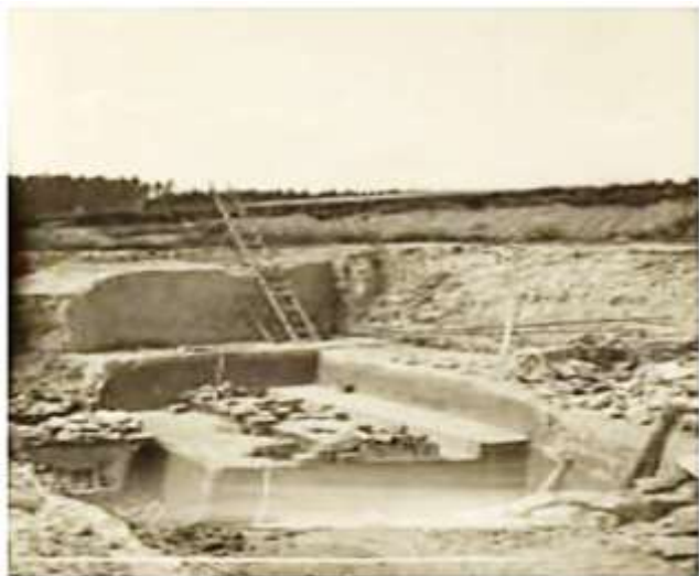
Grube Concordia zwischen Ebernahn und Ransbach - Arbeiter die den Ton von Hand abstechen und aufladen
