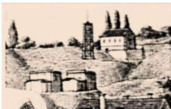
Vier, später 6 U-förmigen Röstöfen in Bendorf
