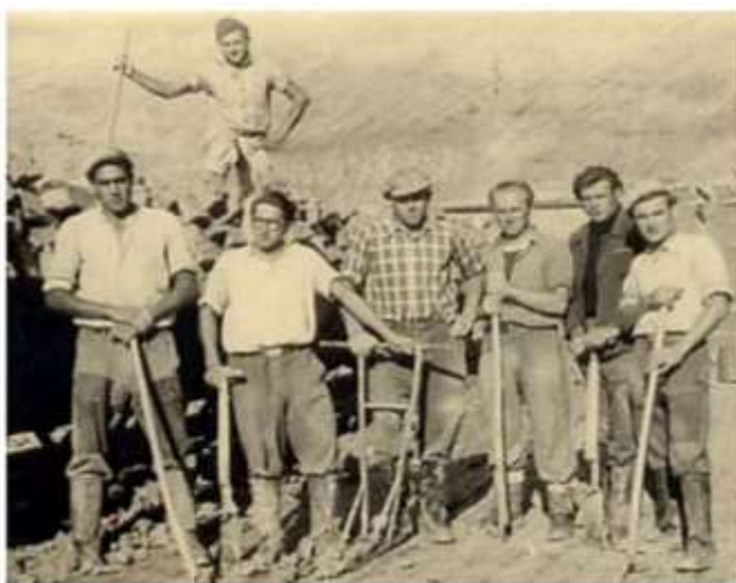
Grube Concordia zwischen Ebernahn und Ransbach - Arbeiter die den Ton von Hand abstechen und aufladen
