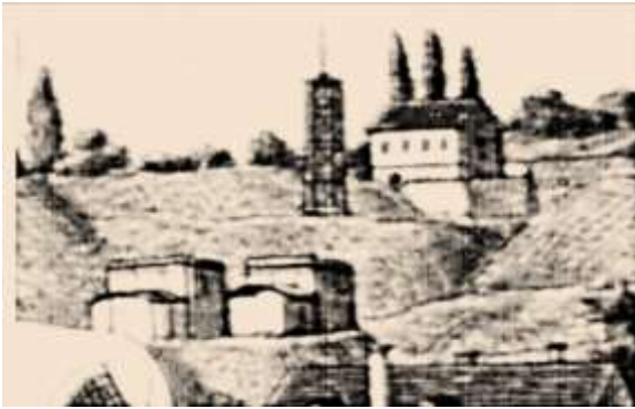
Vier, später 6 U-förmigen Röstöfen in Bendorf
