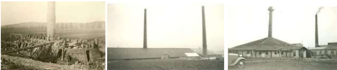
1925 und 1935 Neubau Schamotteringöfen auf Concordia
